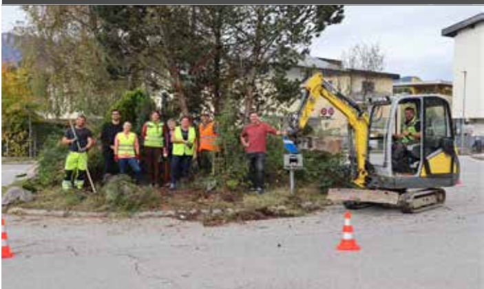
So sah der Kreisverkehr vor den Arbeiten aus
